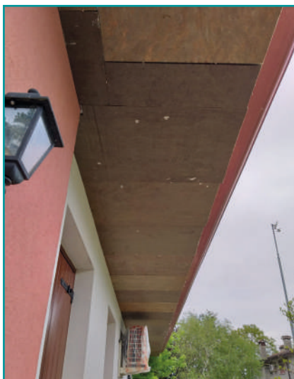
Nobilium®Thermalpanel come correzione ponte termico esterno
