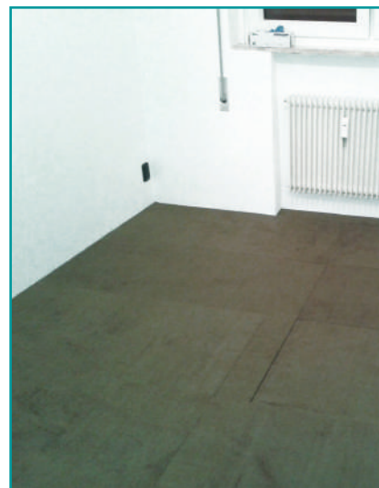
Nobilium®Thermalpanel per l'isolazione termo-acustica a pavimento.
