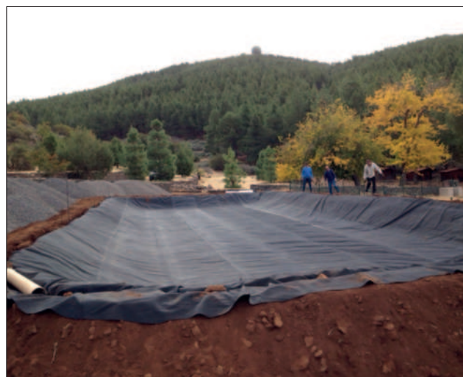
Stesura della membrana Hidrostan® tagliata su misura.
