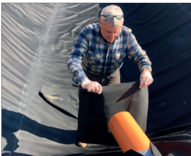
Posizionamento dei raccordi.
