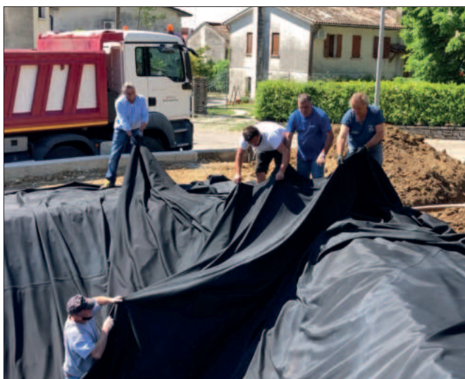
Stesura della membrana Hidrostan® tagliata su misura.
