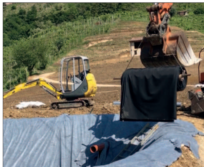
Stesura TNT e posizionamento rotoli Hidrostan®.
