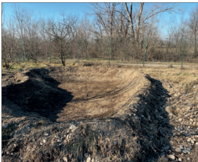
Realizzazione dello scavo e costipazione del terreno.
