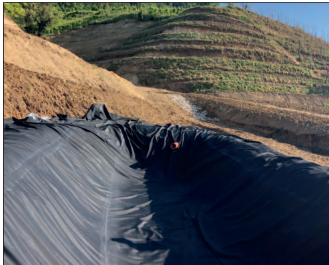
Stesura della membrana Hidrostan® ultimata.
