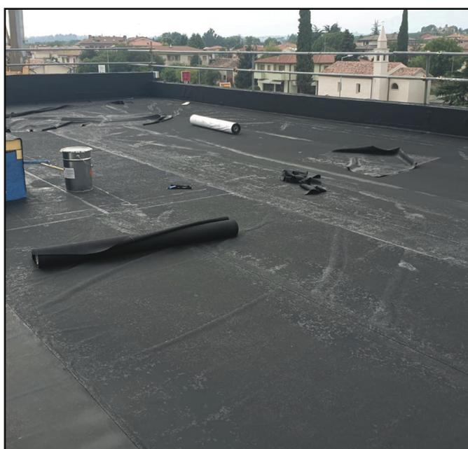
La posa delle membrane **Hidrostan® EPDM**. è semplice e può essere effettuata in qualsiasi momento dell'anno. Le membrane **Hidrostan® EPDM**. possono essere posate in adesione totale, zavorrate e/o fissate meccanicamente, senza la necessità di ulteriori protezioni superficiali.
